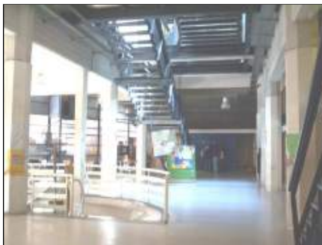
FOTO 8: 1º piso, se ve claramente cuan peligrosa resulta la escalera central para quienes no la pueden ver (ni localizar a tiempo con el bastón). Foto tomada desde Bedelía para marcar cómo sería distancia alfombra hacia ascensores.
