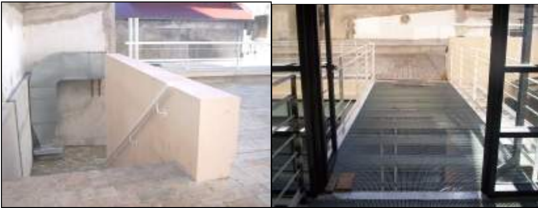
FOTOS 14 y 15: Barandas escaleras y posibilidad de realizar un camino de acceso con piso de goma para personas con discapacidad visual.
