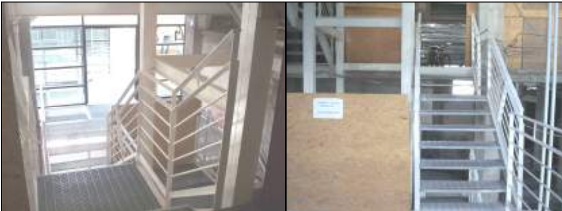
FOTOS 12 y 13: Salones L2 y L5 no se accede hasta instalación de “rampa electrónica” (para dentro del Salón L2 se sugiere ídem salones L4 y L6).
